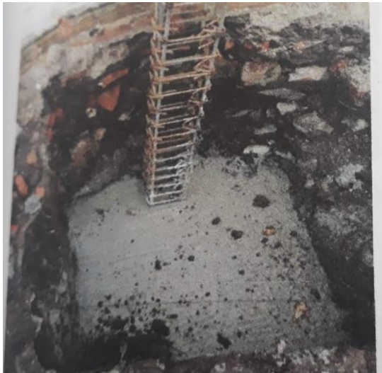
Fotografía 11 Construcción de cimientos-anfiteatro
