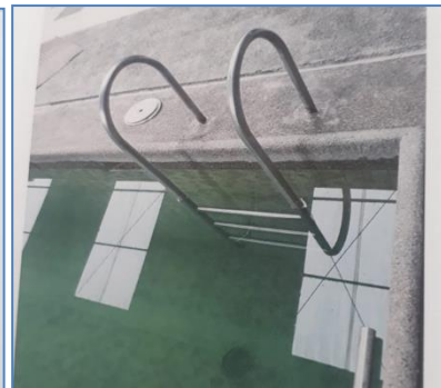
Instalación de escaleras de ingreso a las piscinas
