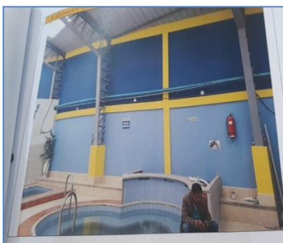
Construcción del hidromasaje
