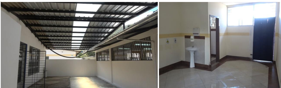
Fotografía 79 Infraestructura para pacientes diagnosticados con COVID-19 construida en el Hospital Miguel León Bermeo
