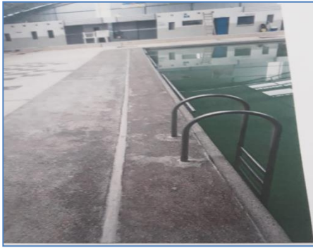
Fotografía 7 Instalación de piso de granito alrededor de la piscina
