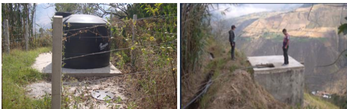
Tanque de Polietileno de 5000 que está sin conectar a la distribución y tanque de distribución
